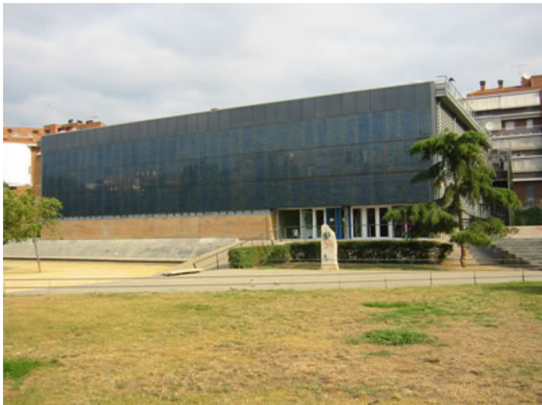
Façade photovoltaïque de la bibliothèque de Mataró (Catalunya)
